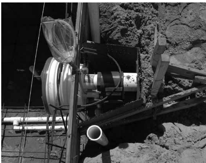
Мал. 7 Встановлення корпусу BADUJET в армовану сталь
